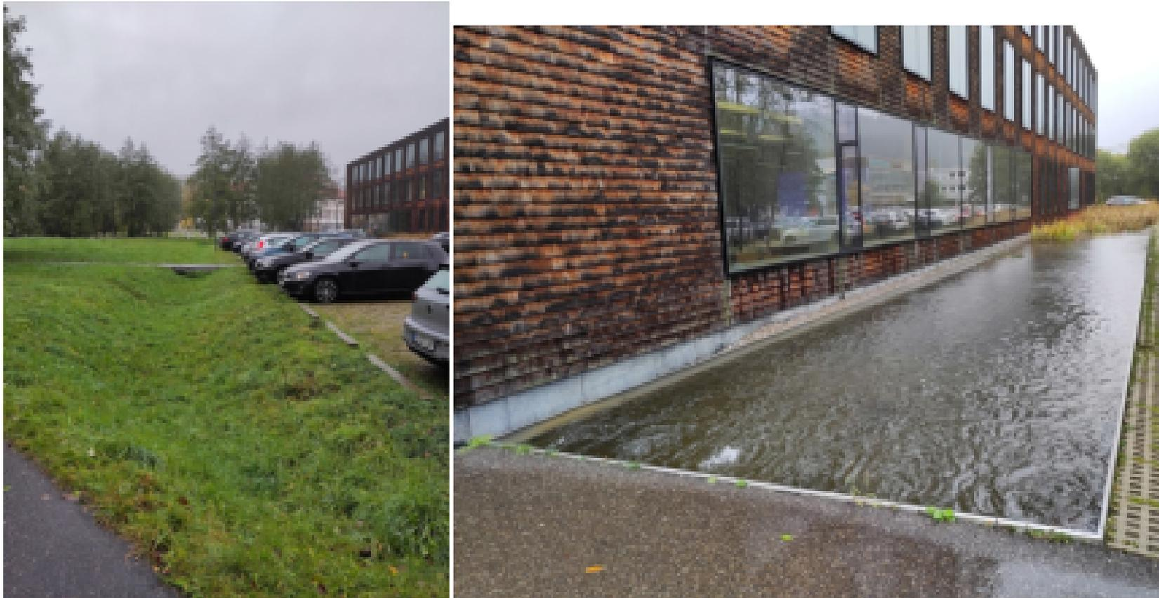
Abbildung 3: Grünmulde entlang des Parkplatzes des I-Gebäudes (links-31289-001) und Wasserbecken an der Südseite des I-Gebäudes (rechts – 31289-002)
