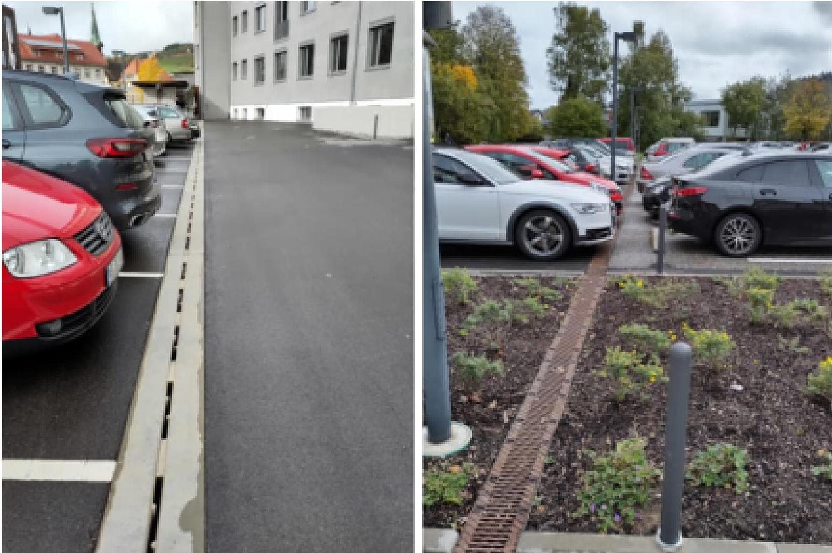
Abbildung 12: Rinnenentwässerung der Parkplatzanlagen des I-Gebäudes
